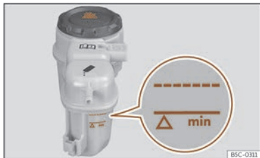
Fig. 239 Dans le compartiment avant : vase d'expansion du liquide de refroidissement.
