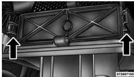
Remplacement du filtre à air du climatiseur
